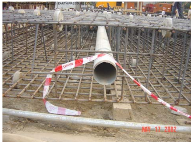
Photo 3. GI casing welded to a reinforcement cage of a diaphragm (D) wall
